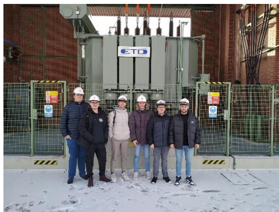
Obrázek 103 Rozvodna Plzeň Černice I
