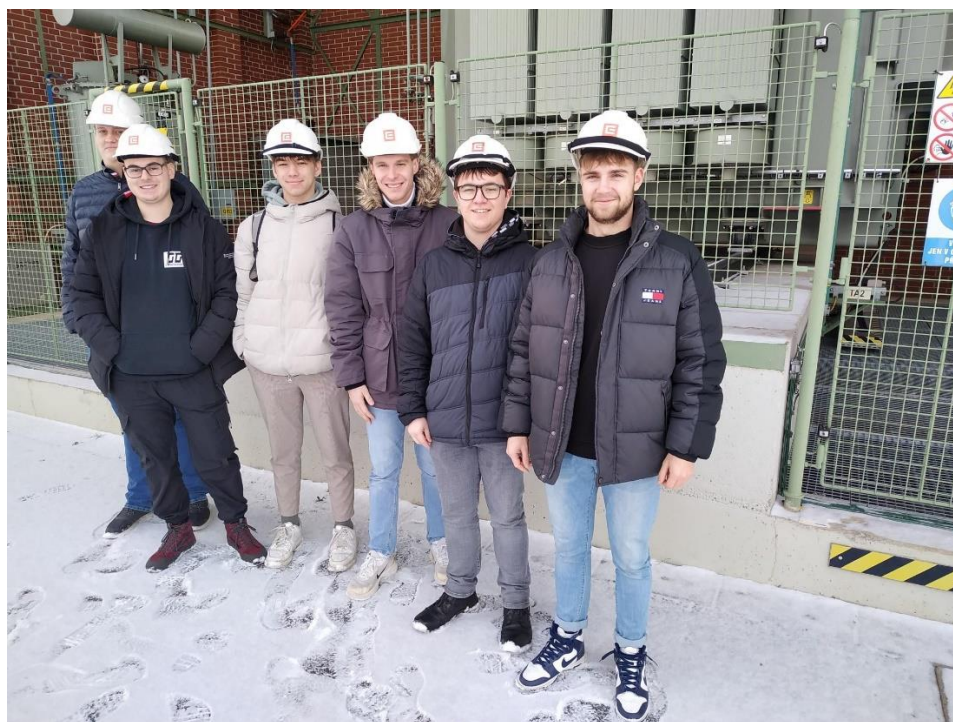
Obrázek 105 Rozvodna Plzeň Černice III
