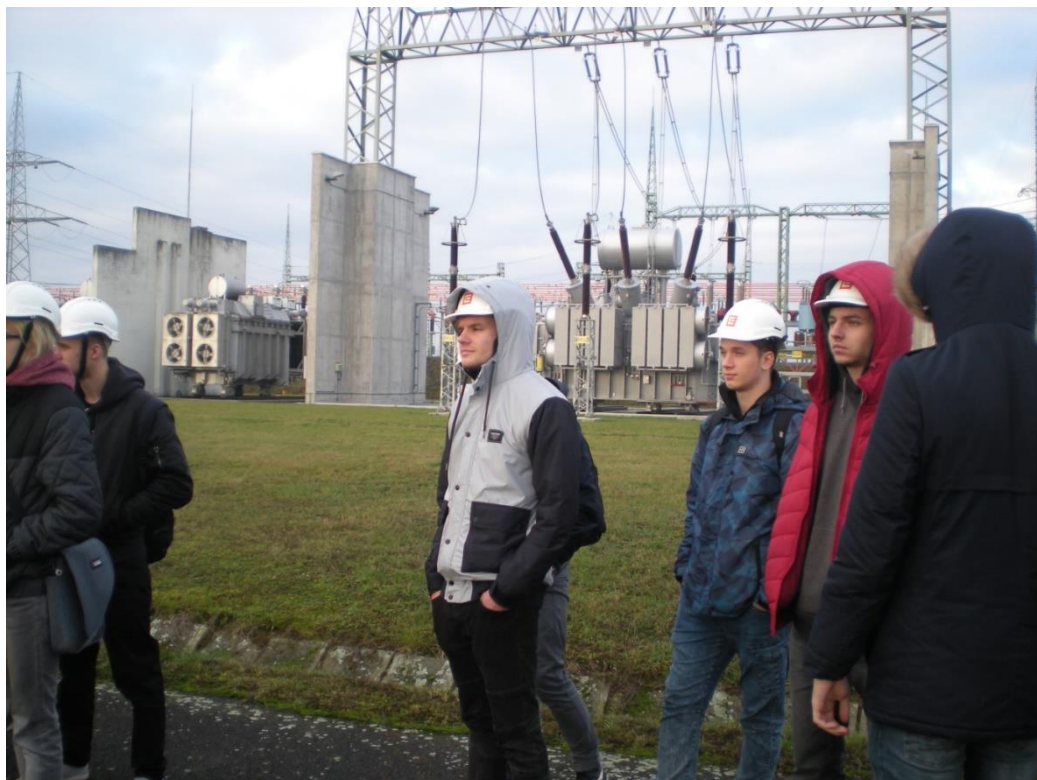
Obrázek 115 Rozvodna Přestice II
