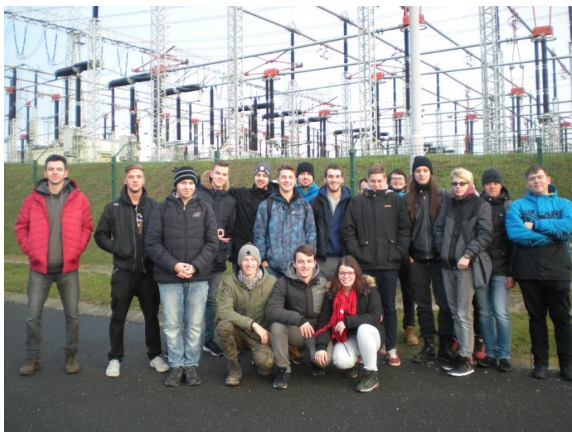
Obrázek 114 Rozvodna Přestice I
